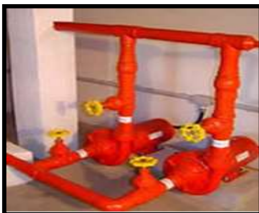
Figura 16 - Bomba de Incêndio
